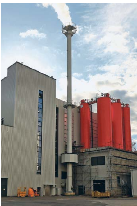
Abb. 4: Die KVA Helmstedt: Mit einer Kapazität von 160.000 t OS erzeugt sie rund 15.000 t phosphathaltige Asche. Sie wird in den vorderen beiden roten Silos für das spätere Phosphorrecycling gespeichert.
